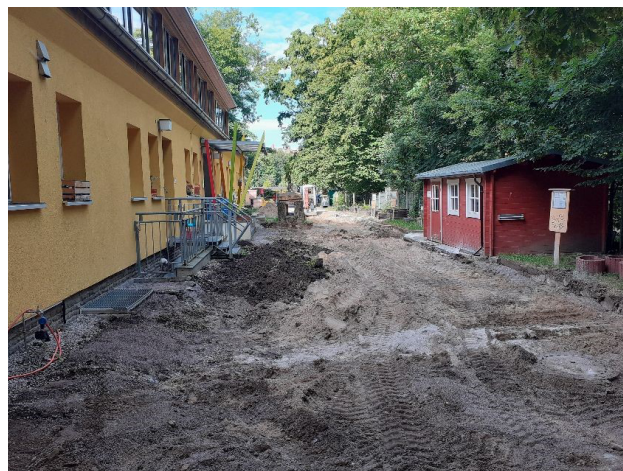
Baustelle Kita Grünschnabel zur Verlegung des W-LAN
